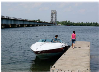
Rampe de mise à l'eau Halte des plaisanciers
